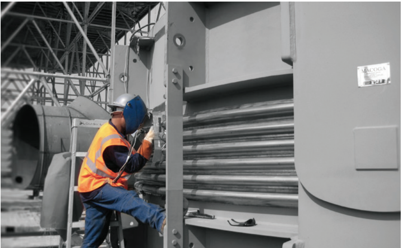
Сборка компенсатора MUX диаметром 7200 мм на атомной станции в Турции
