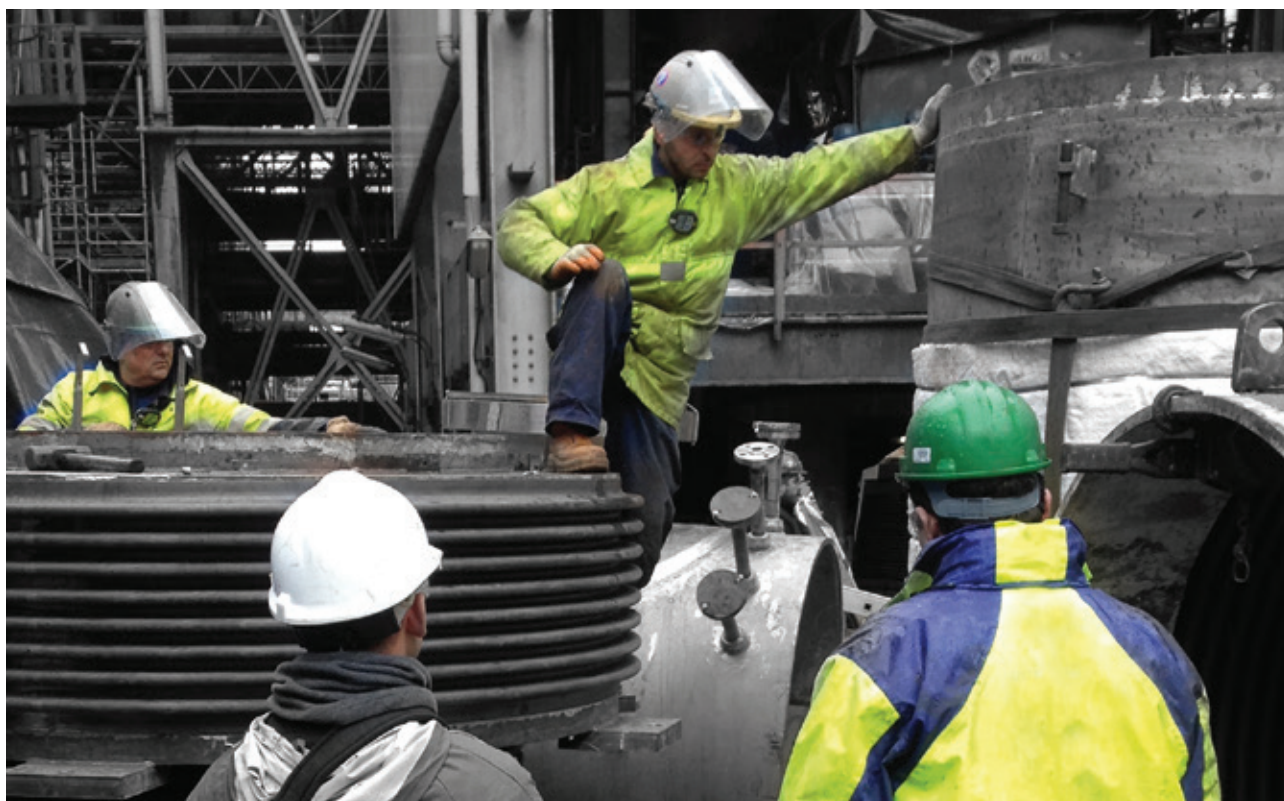
Шефмонтаж компенсатора для FCCU на нефтеперерабатывающем заводе в Испании
